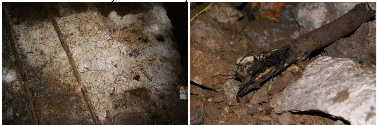
Mycélium noir sur un plancher avant d'arriver au piège n°4
