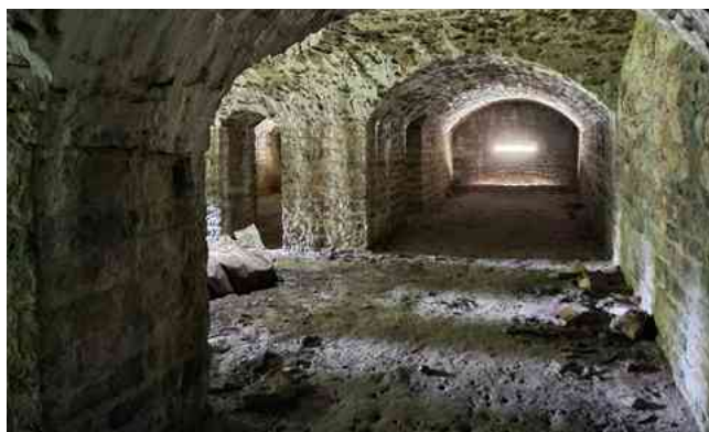
Souterrain du fort de Bron (BL, Bron)
