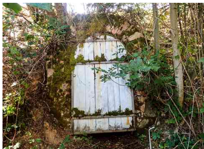
Les galeries des Poudières (BL, 09/09/2015)
