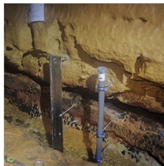
Station hydrométrique située au droit de l'Avalanche
