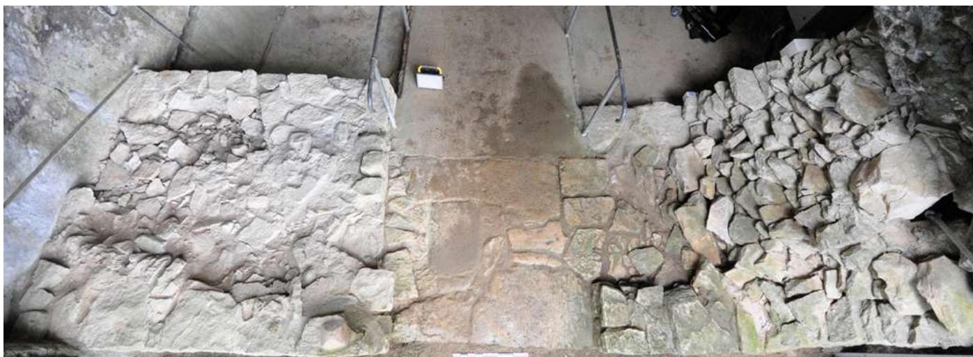
Le mur d'entrée de la grotte Préhistorique d'Azé a été construit entre la fin du VIII e siècle et la fin du X e siècle
