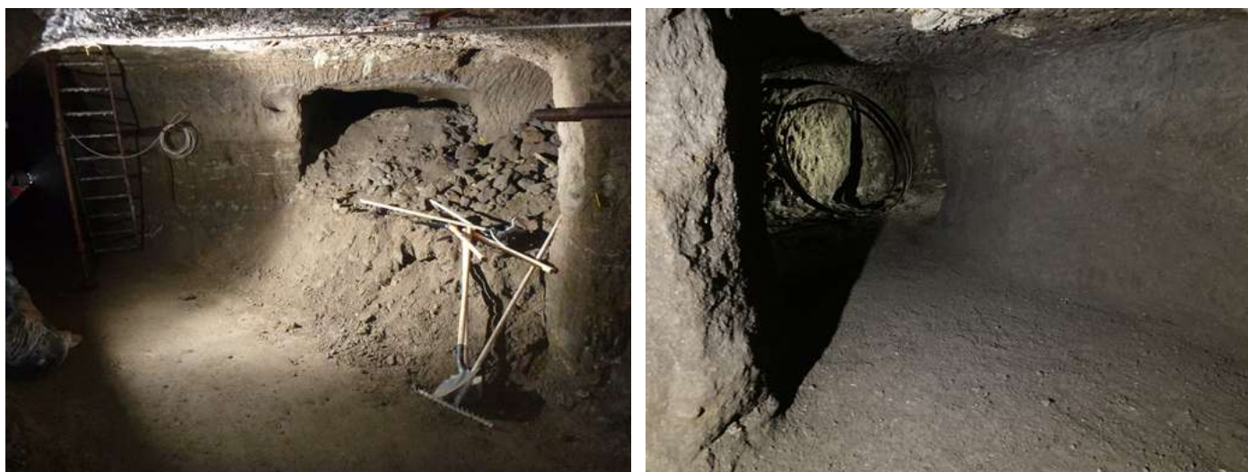
Photos de la galerie de la Baïonnette avant et après désobstruction
