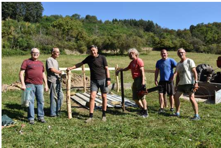
Sécurisation du gouffre du Nière à Château
