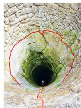
Délimitation en rouge, à la cote 0.00m, de la roche mère accueillant la structure maçonnée et enterrée par endroit de plus de deux mètres.
