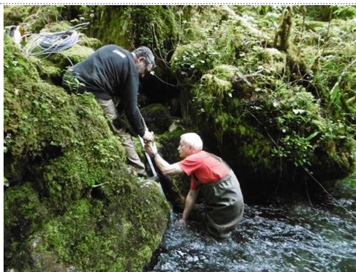
Fig. 4 : Installation de la cellule de mesure otique dans l'Oeil d'Arros. La sonde de niveau d'eau installée tout près nous apprendra que la résurgence avait cessé de couler à l'exutoire seulement quelques jours plus tard. La puissante circulation souterraine n'était plus qu'un ruisseau s'écoulant des blocs et alluvions bien plus bas dans le lit déserté du ruisseau.
