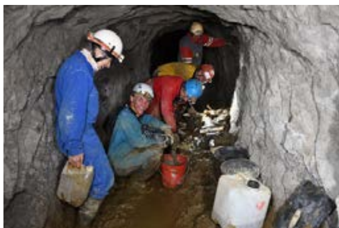
Fig. 12 : réparation de la canalisation dans le tunnel de Saint-Gengoux-de-Scissé.
