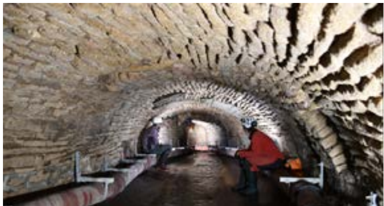
Fig. 5 : égouts de Cluny, vue du Merdasson sous la ville.
