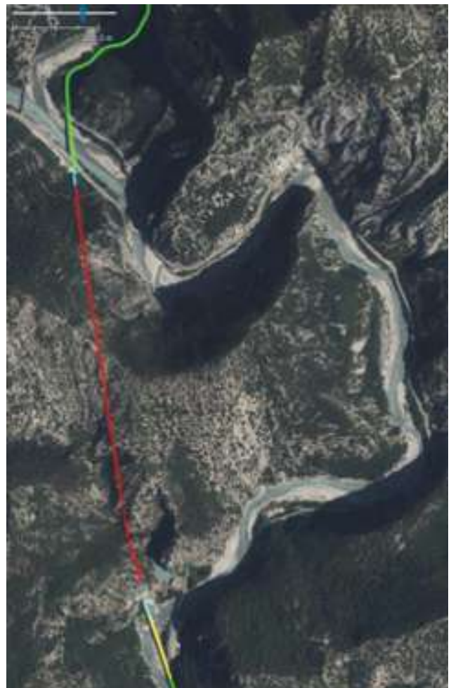
Tunnel de la Mescla dans les gorges du Var. Fond Orthophoto IGN. Trace (vert : solution différentielle complète à quelques centimètres ; jaune : solution différentielle partielle ; rouge : position estimée avec la centrale à inertie).
