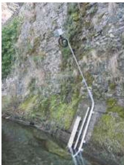
Fig. 3 : largement au-dessus du niveau maximum atteint par les crues en amont du village de Citou, le TRMC-7 transmet régulièrement les données de niveau et de température de l'Argent-Double. En parallèle dans l'étui métallique jouxtant l'échelle limnimétrique, une sonde autonome du type CTD-Diver enregistre la conductivité électrique du cours d'eau.
