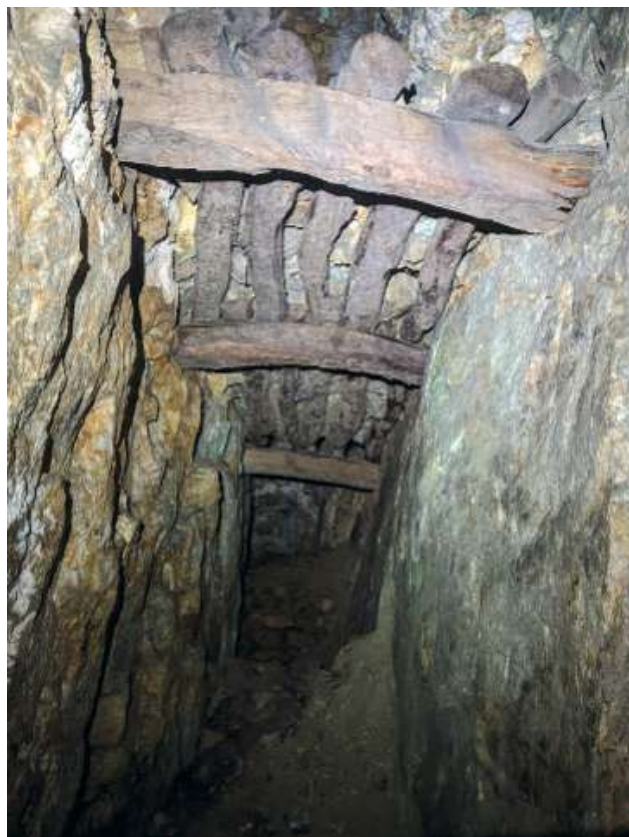
Fig. 10 : plateforme dans le second puits, vue du dessous.
