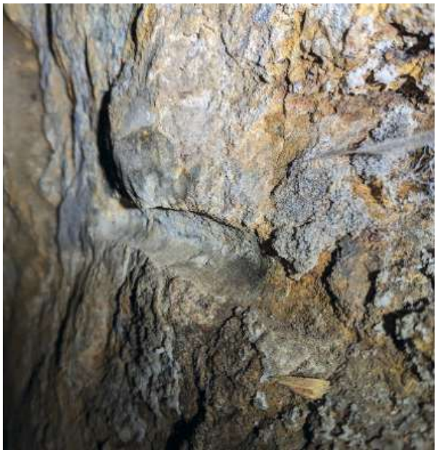
Trace de fleuret de 2,5 cm de diamètre dans la galerie G-10 (Cliché B. Delorme 2023)
