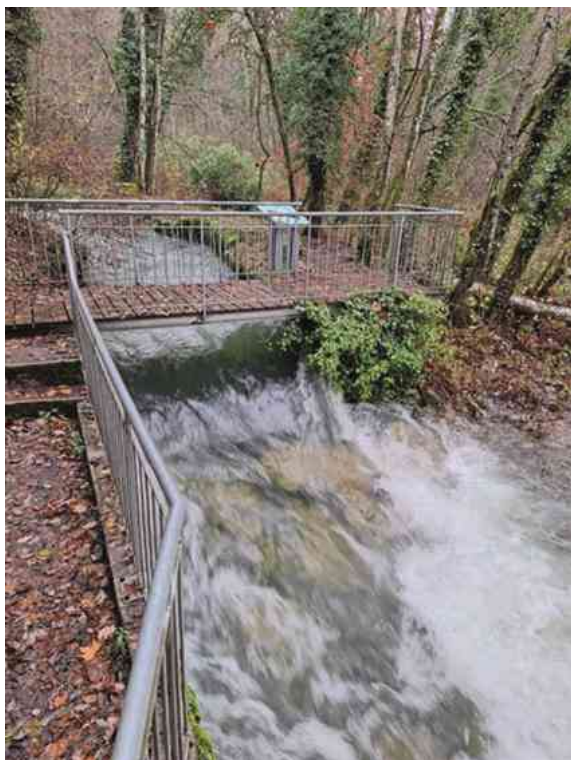
Figure 17 : Lors d'une crue, l'eau passe sous la passerelle
