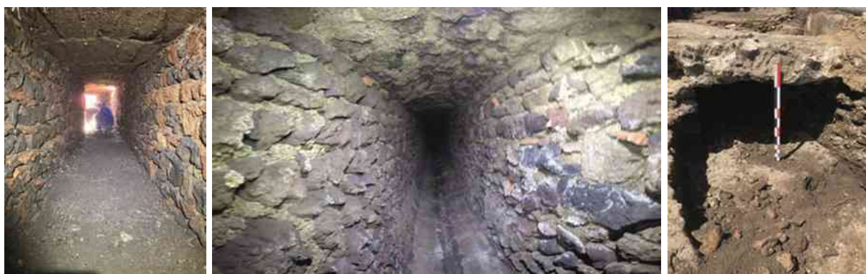
Figure 6 : Topographie de l'ancien réseau d'évacuation d'eau pluviale
