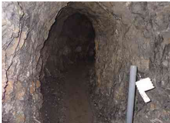
Figure 4 : Grotte du rocher du taureau, tunnel artificiel permettant le contournement d'un siphon
