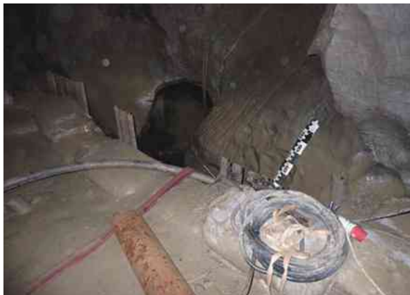
Figure 3 : Grotte du rocher du taureau, pompage permanent d'un siphon
