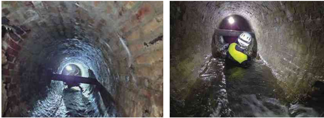
Figure 4 : À l'intérieur du souterrain
