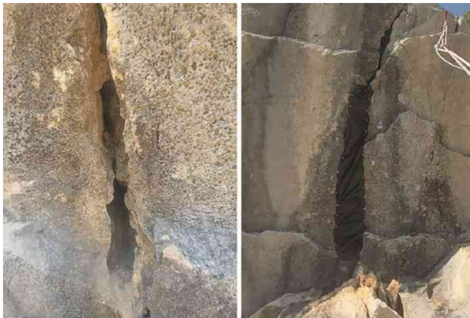
FIGURE 4 : EXEMPLE DE BOUCHAGE DE FISSURE A L'AIDE DE GEOTEXTILE ET DE CHEVILLES A FRAPPER (COMPARTIMENT D)
